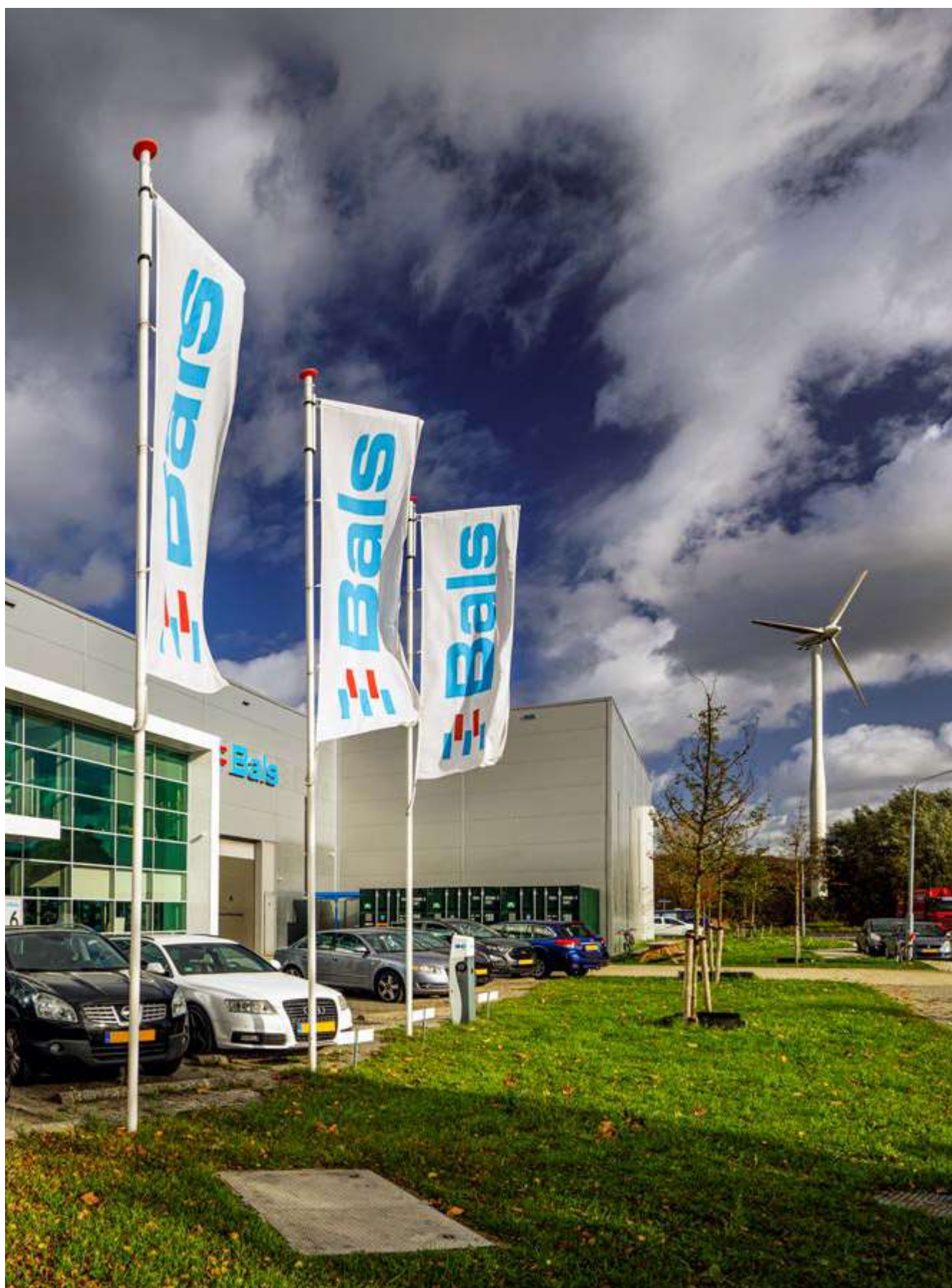
Energie neutrale werkplaats en kantoor Bals Nederland BV te Haarlem
